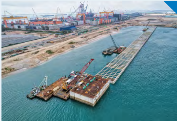
↗ Installation of caissons at TTP1
